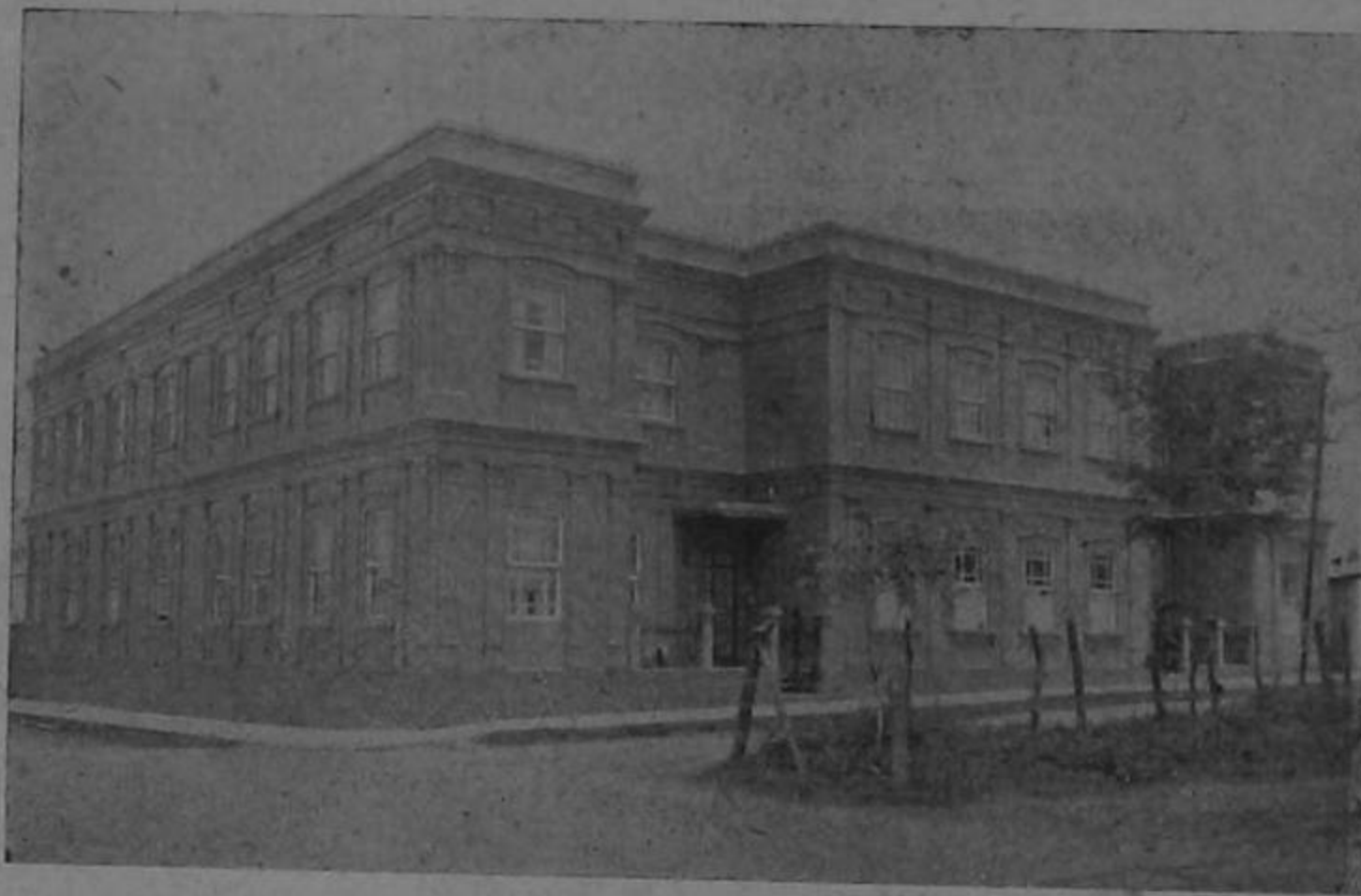
Edificio de oficinas, clases y misioneras.
